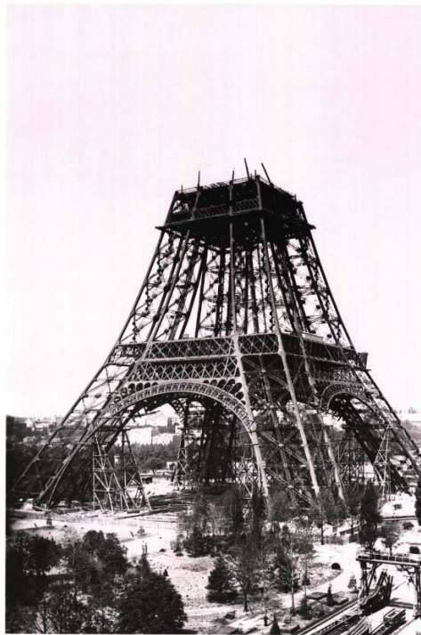
CONSTRUCTION DE LA TOUR EIFFEL.1887-1889
